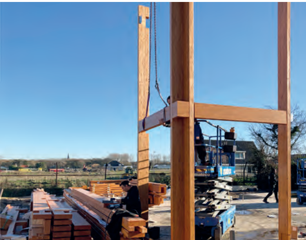
Links: De houten constructie is geproduceerd door De Groot Vroomshoop en als bouw pakket op de bouwplaats aangeleverd.
